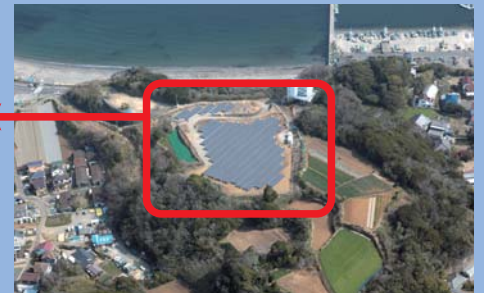
みうら太陽光発電所
