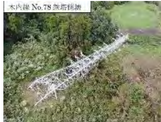
左) 近年々々水災害による被害総額は増加している。(国土交通省) 右) 経済産業省「令和元年に発生した災害の概要と対応」より千葉県君津市で倒壊した鉄塔の写真
