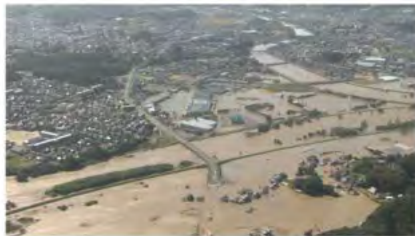
令和元年東日本台風による被害 (福島県での阿武隈川の氾濫)
