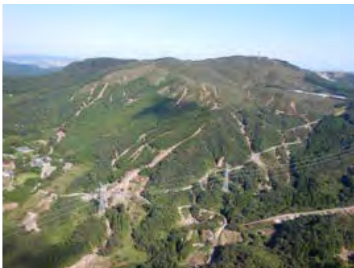
山腹崩壊の発生(宮城県丸森町) (令和元年東日本台風)
