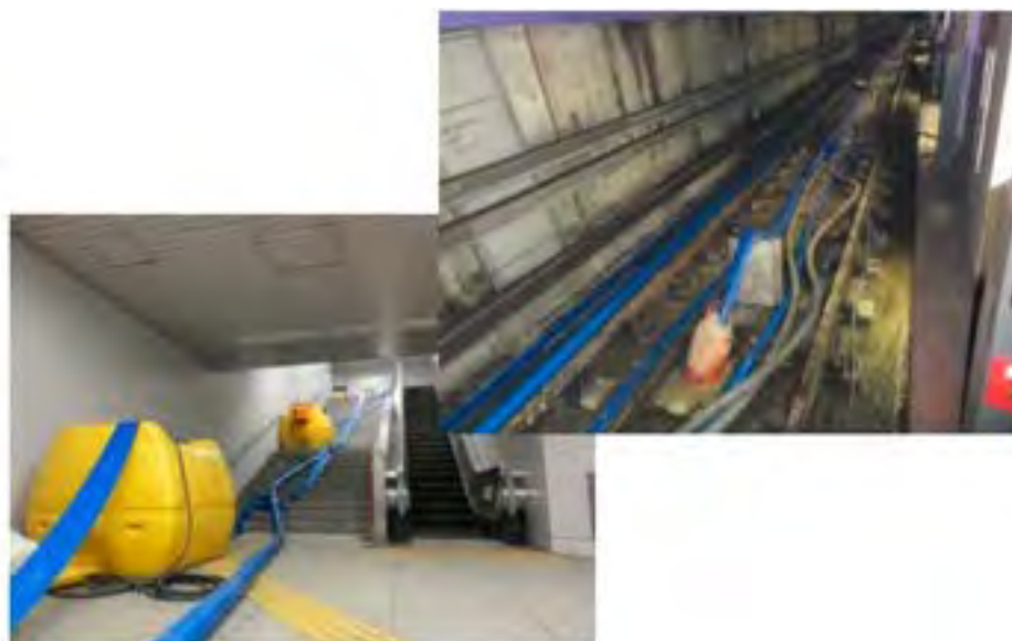
地下鉄駅におけるポンプによる排水 (平成25年台風18号における地下鉄の浸水)
