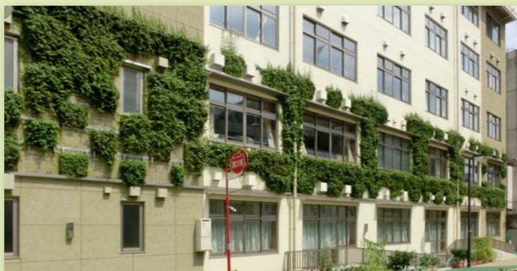
(壁面緑化)久松小学校・久松幼稚園
