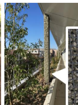
ジャカゴ樋（全体）
